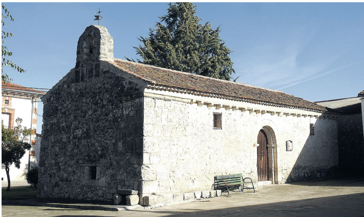
Fuentepeñel. Ermita de Santa Brígida.
