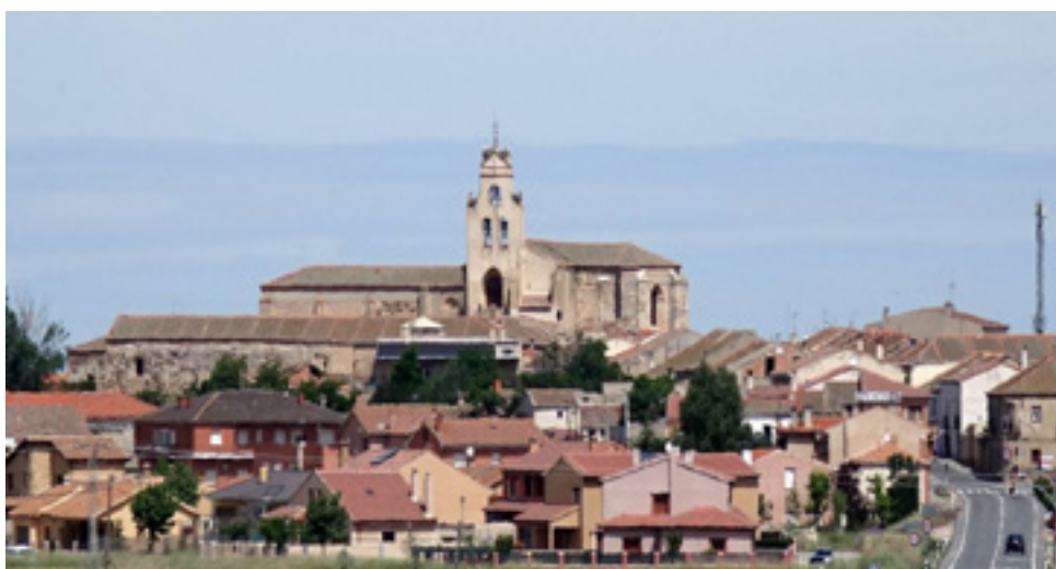
Iglesia parroquial de Santa María la Real de Nieva, desde la entrada de la carretera de Segovia, CL-605. Foto: I. Marqués.
